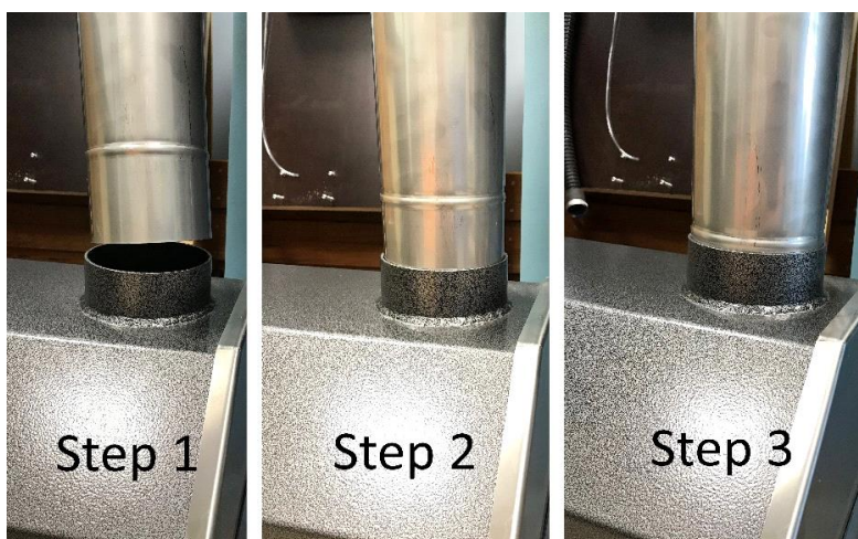
Kuva 7. Savupiipun asennus
